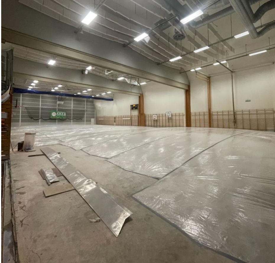
Bilde 3: viser fjellhallen høsten 2023, som reetableres etter stormen.
