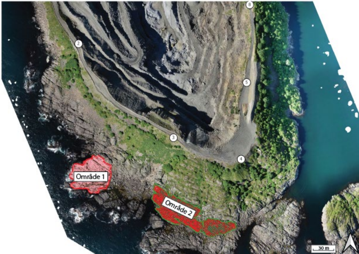
Figur 4-3: Dronebilde som viser sørsiden av steinbruddet og områdene der sprekkene er kartlagt topologisk.
