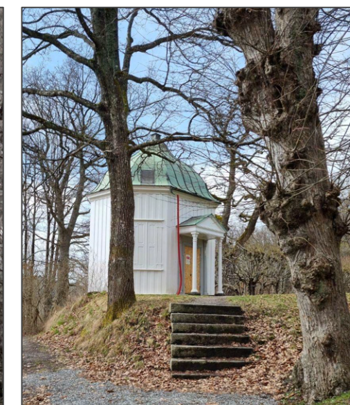
FIGUR 30 - Nyere foto under av paviljongen under restaurering (Hermstad, 2023).
