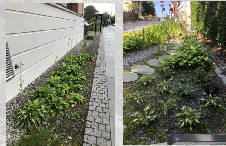
Foto: Regnbed i Haugeveien 3 (til venstre) og deler av regnbedet i Haugeveien 13
