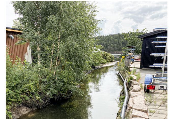
1 Utløpet sett fra kulverten i nord, Oslo kajakkklubb på høyre side og Thaugland trevareforretning på venstre side.
