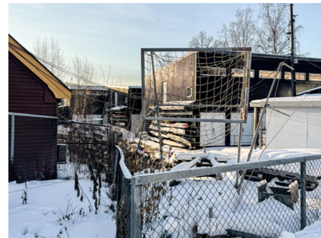
4 Sikt fra gangveien som går forbi bekkeutløpet. Sikten er delvis hindret av gjerder, vegetasjon og rot.
