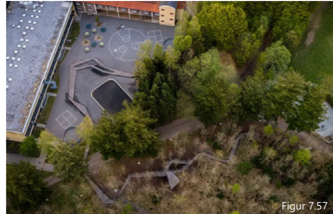
Oversiktsbildet over Skørping skole viser loopen som strekker seg over både asfalterte flater og gjennom vegetasjon. Figur 7.57
