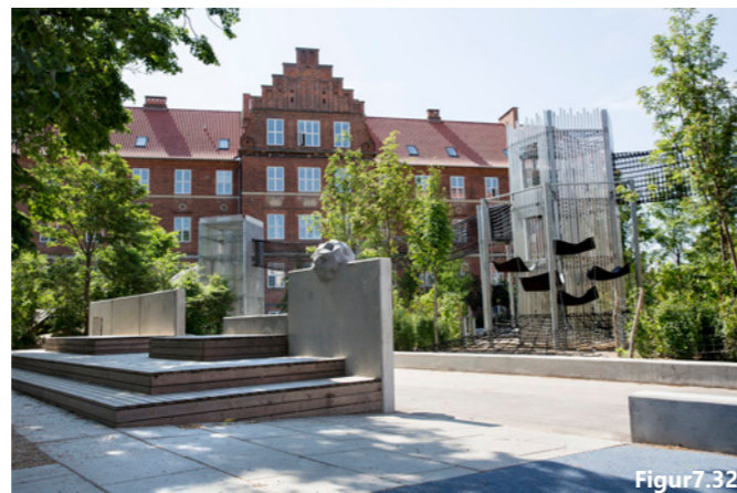
Bildet er tatt fra gaten på utsiden av skolegården. Det er noen åpne veier inn til skolegården, men betongkonstruksjoner og konstruksjoner i treverk som innbyr til lek skaper likevel rammer på skolegården.
