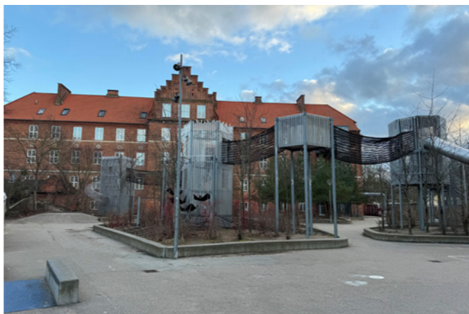
Bildet viser deler av et større klatretårn på Amager Fælled skole.
