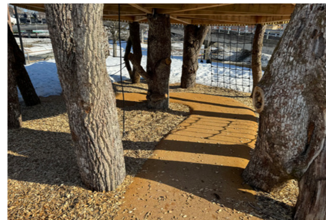
Dekket rundt er i hovedsak bark, men det er også laget en sti i helstøpt gummidেকে som skaper mulighet for universell ferdsel.
