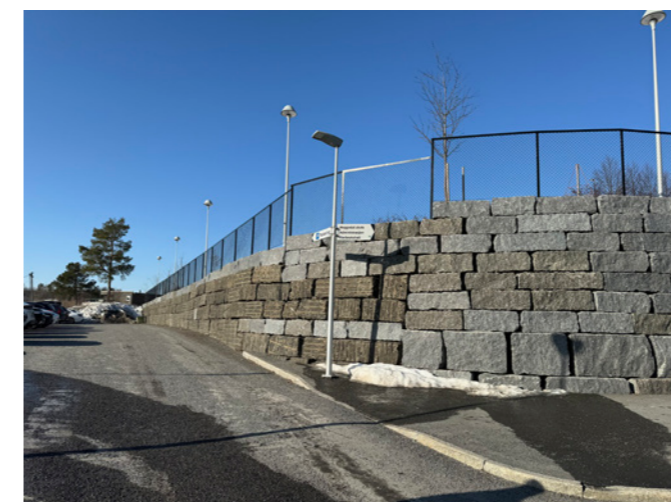
Muren i sør har en økende høyde fra vest til øst.
