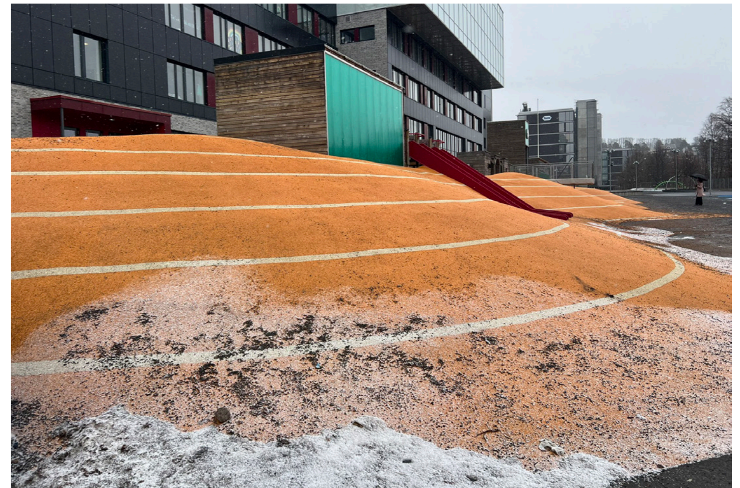
Bildet viser hvordan helstøpt gummi blir brukt for å “forme landskapet og holde masser på plass” (Ottesen et al., 2011, s. 13) på Brynseng skole i Oslo.
