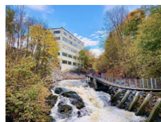
Figur 2.1. Bryggekonstruksjon langs elva. Foto: Nilsen et al. (u.å.a).
