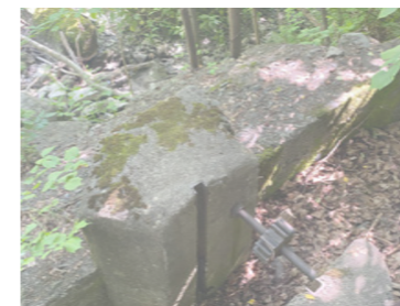
C. Møllefundament, detaljbilde. Nedenfor Møllefossen er det idag fundament etter gammel mølledrift i forbindelse med bekken.
