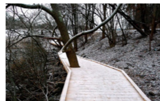
Figur 4.12. Tre implementert i brygge. For å bevare vegetasjonen, vil den få ta plass og være ledende i utformingen av bryggene. Bygdøy Kyststi, Østengen & Bergo. Foto: Østengen & Bergo (u.å.).
