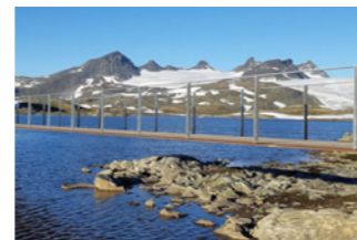
Figur 4.11. Luftig bro med stålrekkverk. Infallsport Jotunheimen nasjonalpark, Dronninga landskap. Foto: Dronninga landskap (u.å.).
