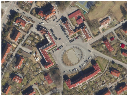
Figur 91. Dagens situasjon (Norge i bilder, 2023). Plassen er asfaltert og det er parkering
