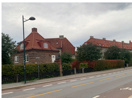
Figur 17. Portnerbolignene, ligger en på hver side av Sognsveien
