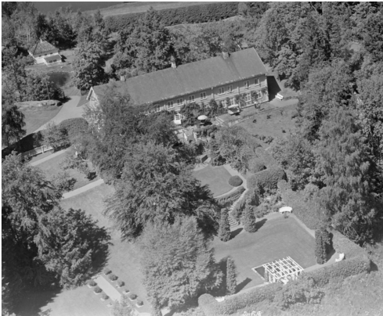
Figur 51. Flyfoto over hagen på Ekeberg. Her ser man at hagen er rammet inn med stramme hekker, med sti langs hekkene. Nederst i hagen i midten av aksen finner vi et speilbasseng, ved en pergola.
