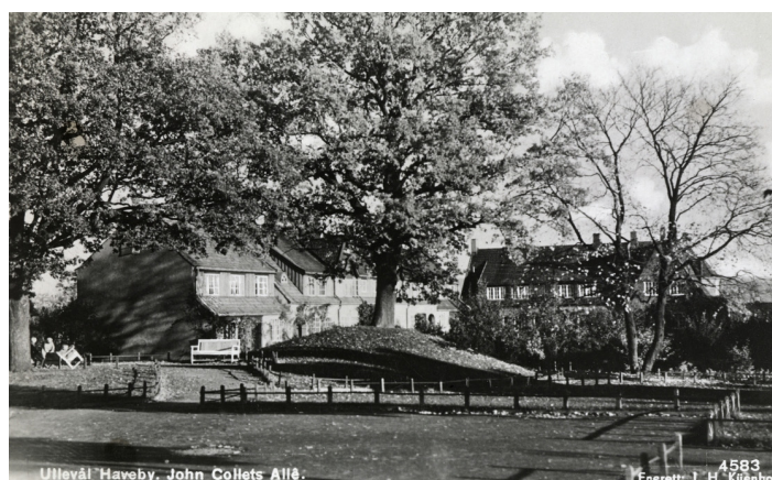
Figur 61. Langliaparken er også planlagt med løpegjerder og hvite parkbenker. Gravhaugen med et stort eiketree framstår som parkens midtpunkt, og man ser at man har lagt en slyngende sti mellom gravhaugen og et annet stort tre. Her tydeligjøres at man så viktigheten av å ta vare på den ekistsernede vegetasjonen og historien i hagebyen når man utfomet nye uteområder.
