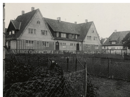
Figur 116. Opprinnelig var det transparente nettinggjerder/flettverksgjerder inne i kvartalene og i skillet mellom hagene.
