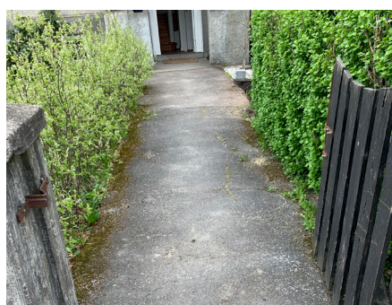
Figur 120. Flere har i dag valgt å asfaltere/støpe den opprinnelige gruslagte stien fra porten til inngangen.
