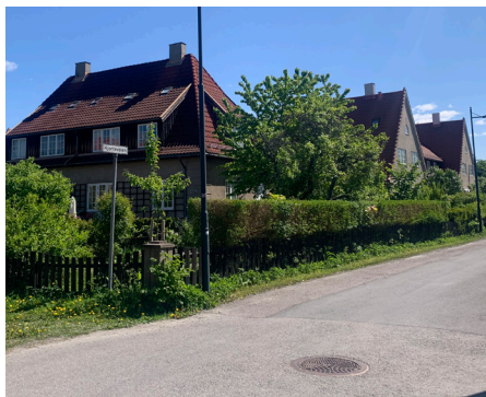
Figur 103. Hage med gjerder ut mot veien. Her ser man at det er plantet hekk langs gjerdet.
