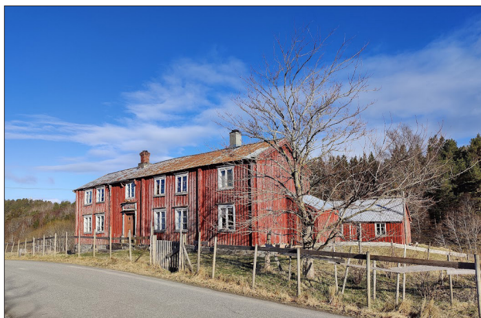
Figur 52 Våningshus på Bu bygd på midten av 1700-tallet. Bygget er SEFRAK-registrert.
