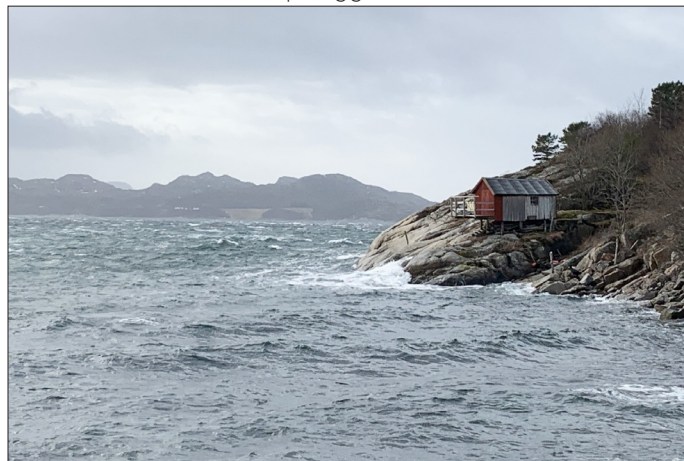
Figur 70 Brettingvorpa på sine siste dager. Like etter bildet ble tatt, raste bygget.
