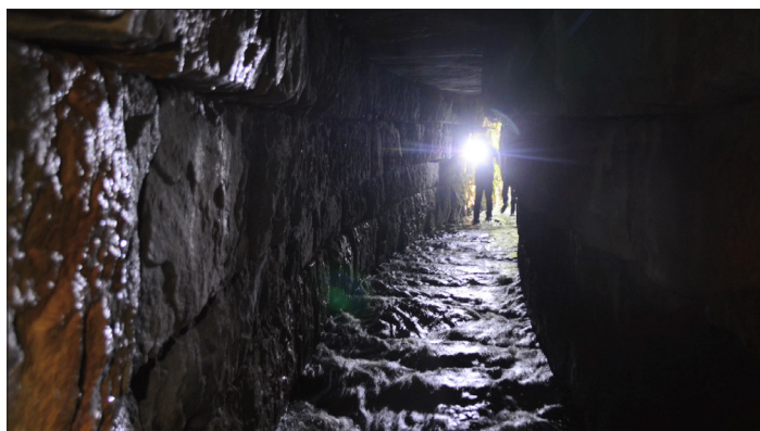
Figur 53 Stikkrenna i Vassdalen. Denne er mer som en vasstunnel.
