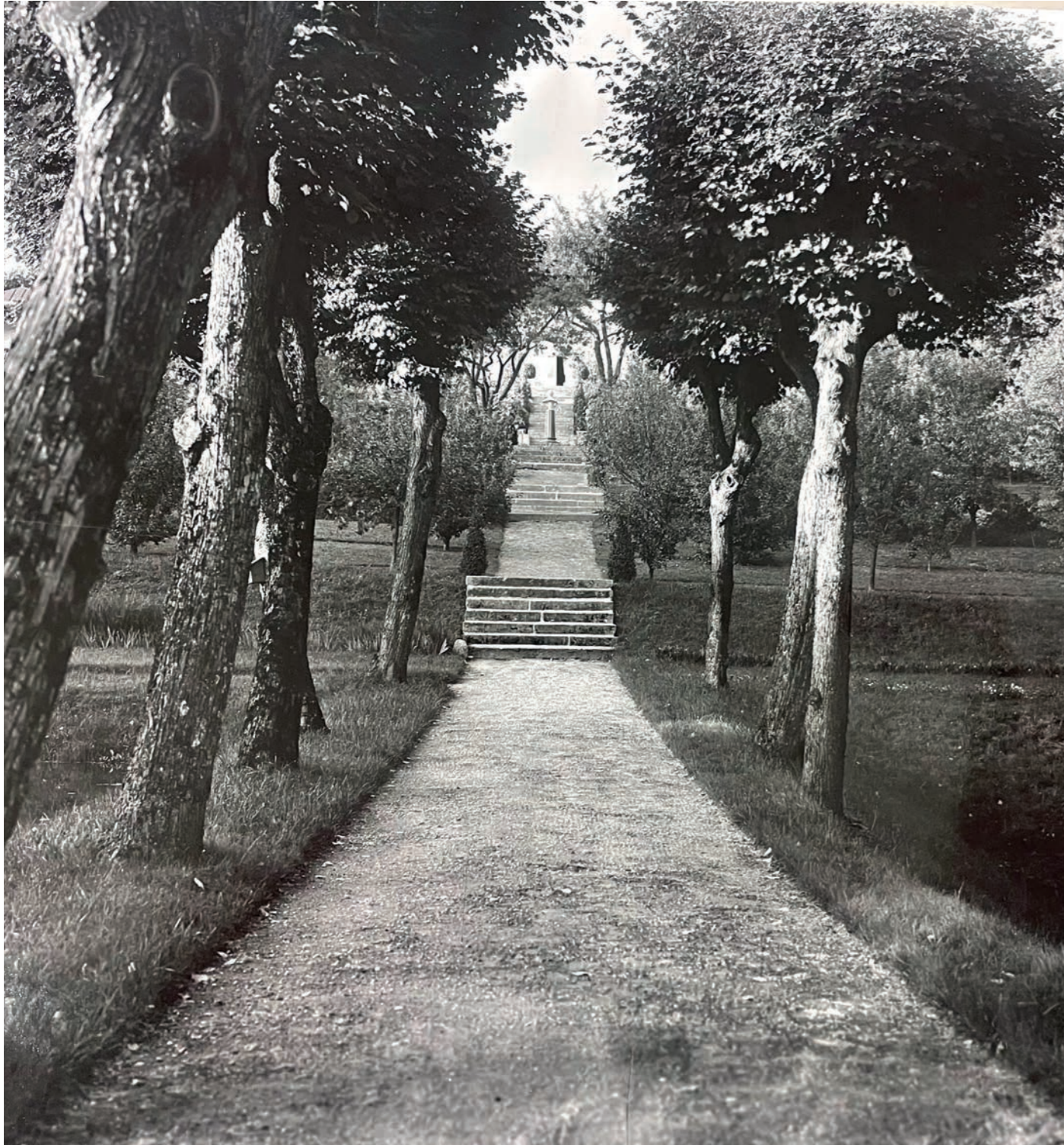
Figur 2.2: Midtaksen mot huset sett fra Havepaviljongen. Bildet er tatt etter Marius Røhnes rekonstruksjon på 1920-tallet. Enger, ca. 1920.
