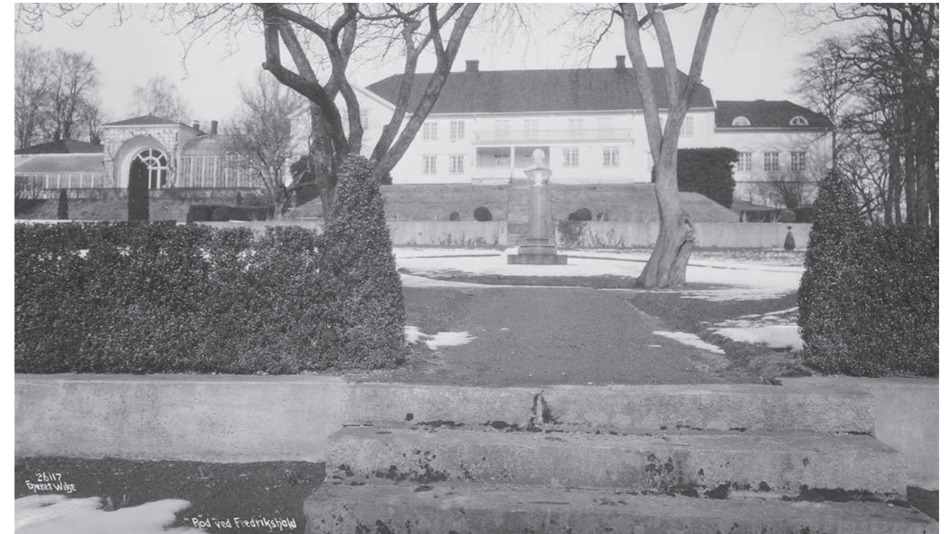
Figur 6.31: Etter ombyggingen blir det støpt murer opp mot bysten, og en hekk blir plantet på oversiden.
