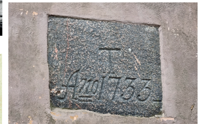
Figur 4.23: T 1733 står innskrevet i grunnmuren til østfløyen.
