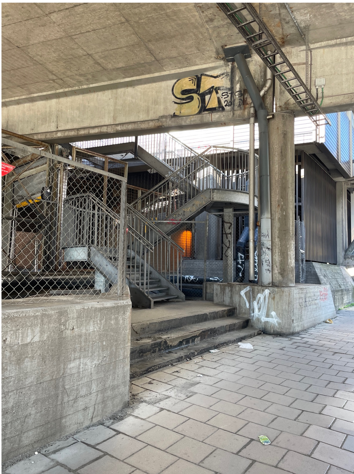
Figur 9: Sprinkeltrapp, adkomst til Nylandsbrua. Foto: Sofie Pascual
