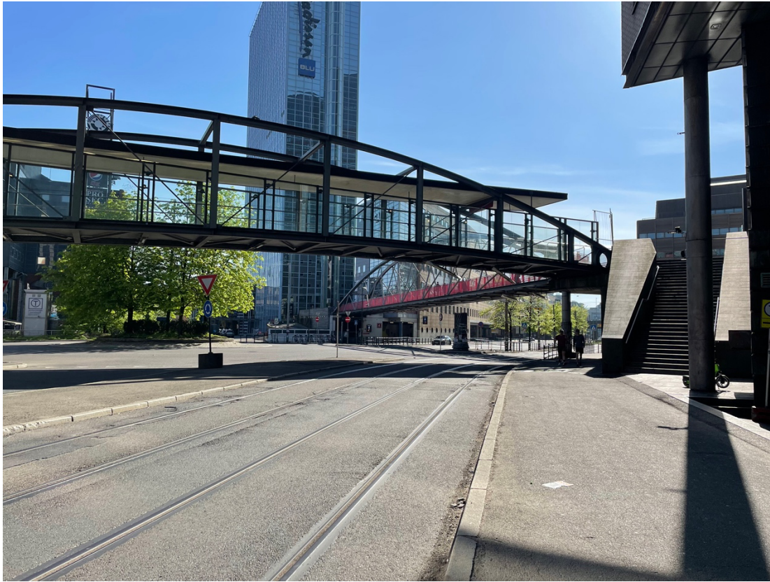
Figur 4: Opphøyde gangbroer på nordsiden av Oslo S. Foto: Sofie Pascual
