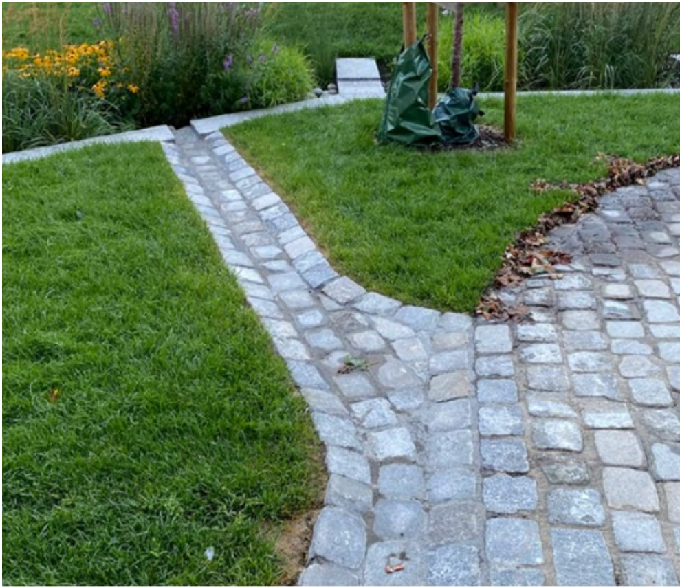
Fig. 63: en av rennene i regnbedet i Maridalsveien kort tid etter anleggelse.
