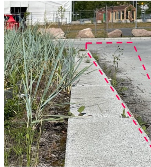
Fig. 61: regnbed B2 har en forhøyet kant. Markert med stiptet linje vises ansamlingen av grus langs regnbedskanten. Dette tyder på at vannet har samlet seg her og ikke kommet inn i selve regnbedet.
