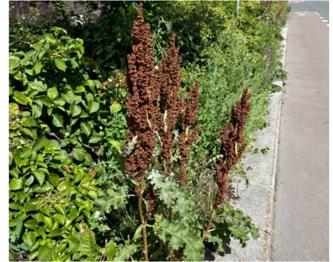
Fig. 57: Bilvei-siden er mer preget av ugress enn gangvei-siden.
