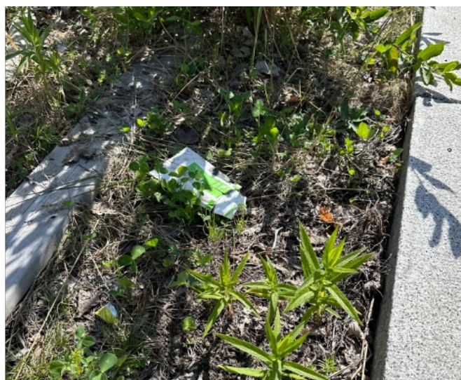
Fig. 24: Glissen vegetasjon, forsøpling og planke-rester ble observert.
