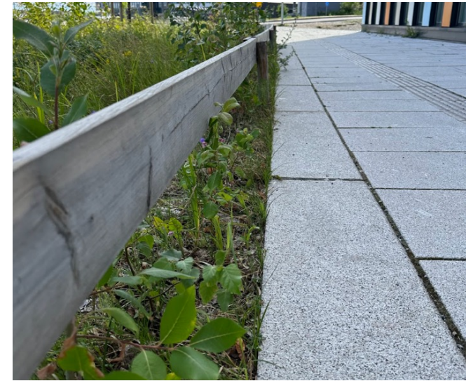
Fig. 19: Anlegget ligger i flush med det omkringliggende dekket. Det skaper en skarp og ryddig overgang.
