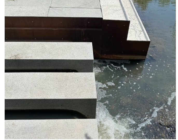
Fig. 45: Stepping stones for å kunne krysse bekken skaper spenning og opplevelse.
