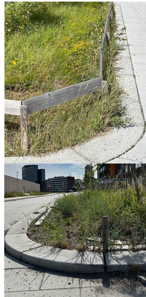
Fig. 58 og fig. 59: øverst er regnbed B1 og nederst er regnbed B2. Begge anleggene hadde i utgangspunktet et midlertidig tre-gjerde for å forhindre tråkk. I regnbed B2 har gjerdet forfalt og det ser ut til at dette regnbedet er mer preget av tråkk.
