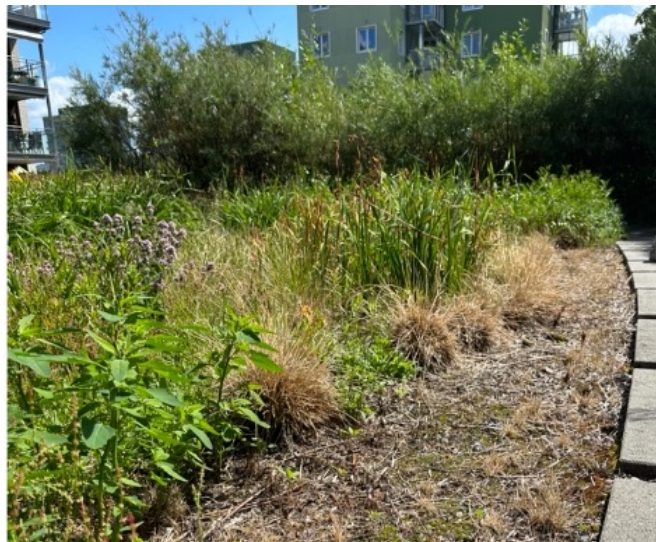
Fig. 5: Dårlig vekst er mest fremtredende i regnbedets ytterkanter.
