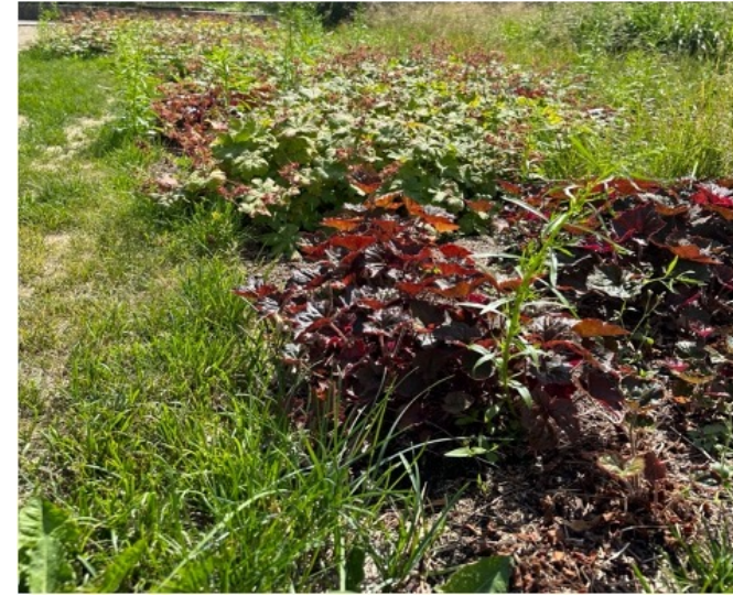
Fig. 9: Diffus overgang fra regnbed til gressplen der det ikke er brukt noen form for kant.
