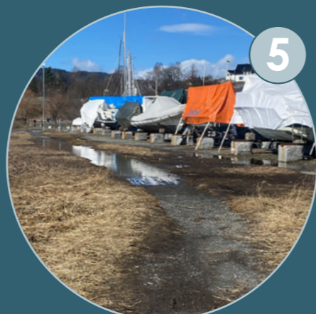
Oversvømt kyststi og opplagsplass i fjæresone.
