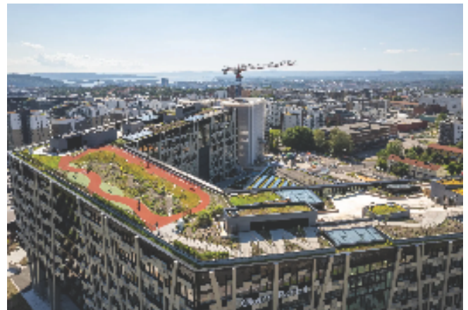
Figur 8: Økern portal. Foto: Vedal.
