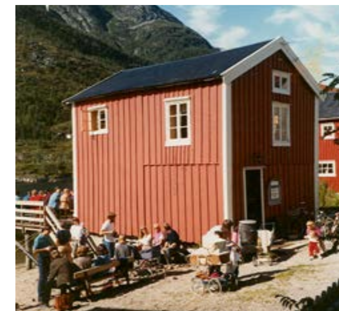
Figur 24: Lydiabrygga etter restaurering. Tilhører Helgeland museum
