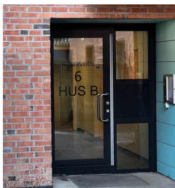
Figur 84 Inngang til leiligheter ved Kværnerbyen. Bildet er tatt av forfatteren.
