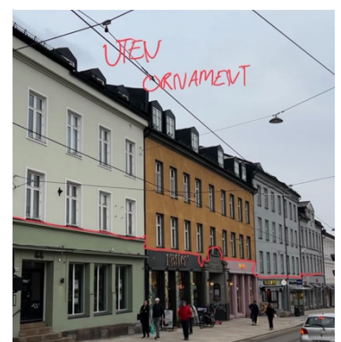
Figur 53 Eksempel på mindre ornamenterte fasader med mer detaljering i første etasje. Bildet er tatt av forfatteren.
