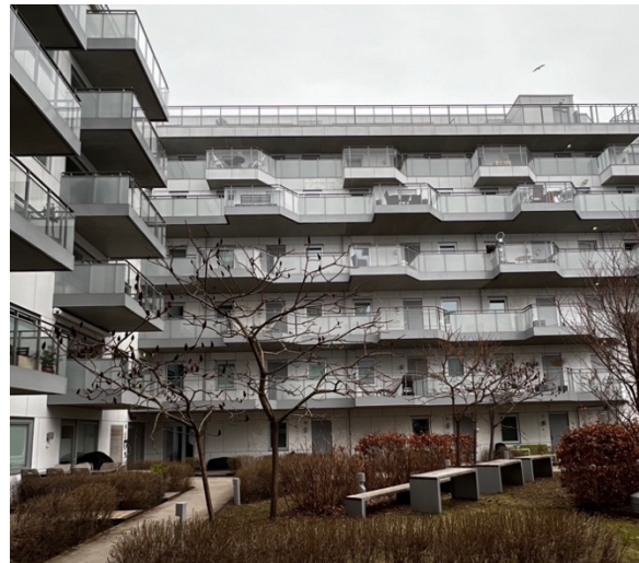
Figur 9 Privat bakgård på Sørenga, Oslo. Bilde er tatt av forfatteren.
