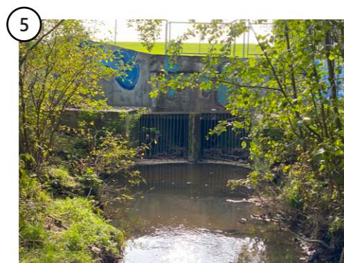
5 Dette er inntaksristen hvor bekken føres inn rør og renner videre 2 km under bakken.
