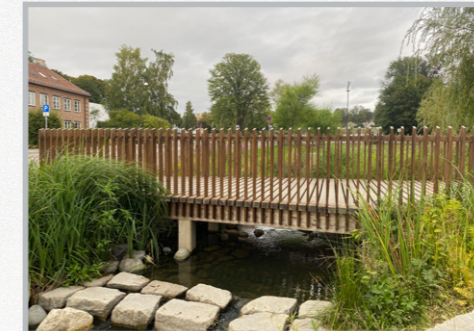
Bilde av trebro over Hovinbekken ved Jordal amfi.
