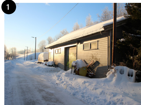
1 Turveien langs Tokerudbekkens åpne løp er godt belyst.
