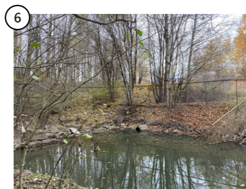
6 Bekken kommer ut ved Haugenporten. Røret ses midt i bildet.
