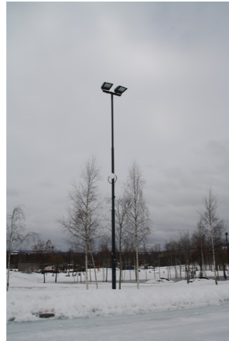
Eksempel på lysmast for flombelysning av skøytebane/basketballbane. Fotballbanene krever andre dimensjoner.
