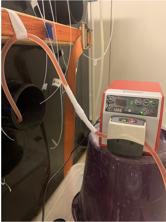
Figur E.3: Oppsett av pumpe. Pumpeslangen er kopla til lekkasjeholet i avløpsleidninga.
