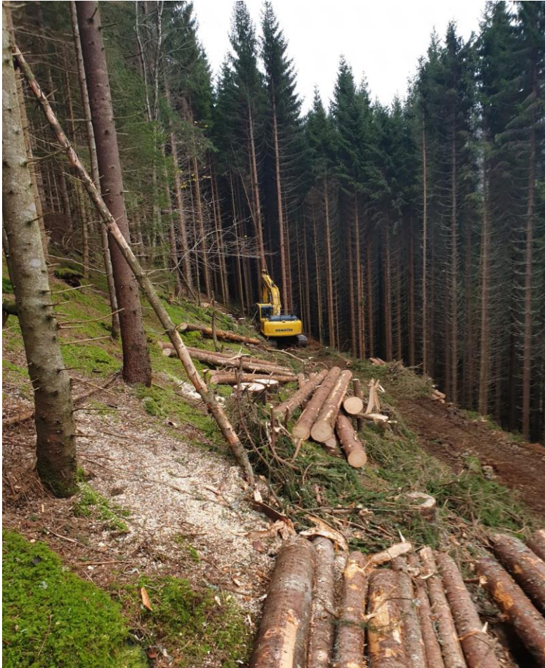
Figur 3. Bildet viser gravemaskin i bratt terreng som bygger en midlertidig driftvei horisontalt for hogstmaskin og lassbærer, maskinene bytter plass etter behov, bilde: Audun With Aasgård
