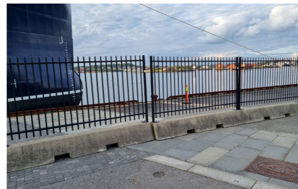
Pumpehuset på Østlige side av Jorenholmen parkeringshus
