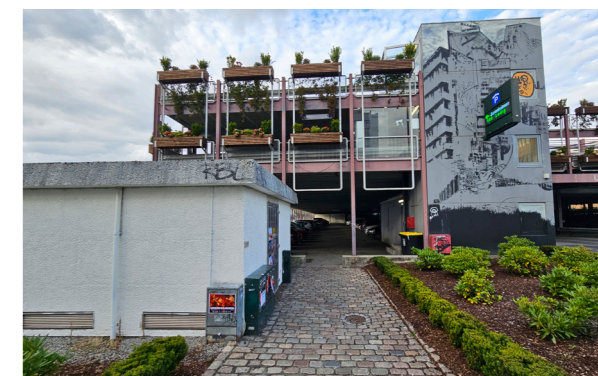
Inngangen til Jorenholmen parkeringshus
