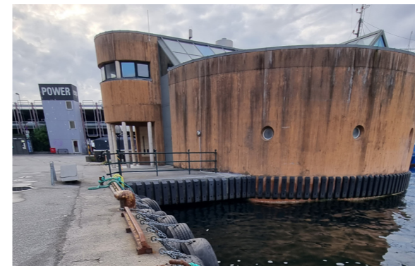
Pumpehuset på Østlige side av Jorenholmen parkeringshus
