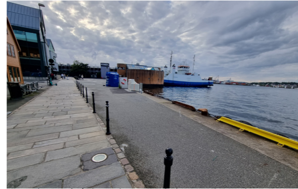
Pumpehuset på Østlige side av Jorenholmen parkeringshus
