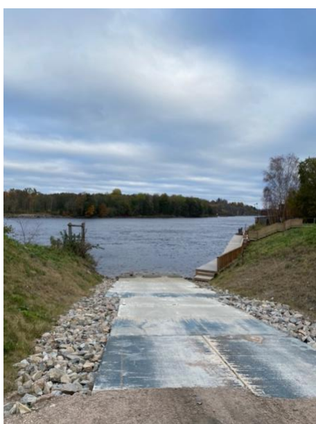
RAMPE NED TIL ELVA GLOMMA
