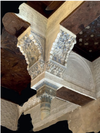
Alhambra, scan av dekkekonstruksjon i tre i vestfløyen. Photo: Martin Ebert
