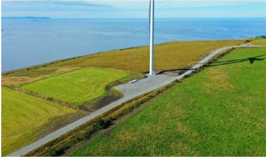
Figur 13: Dronebilde av vindturbin 6. Bildet er tatt av Silje Skarsten.
