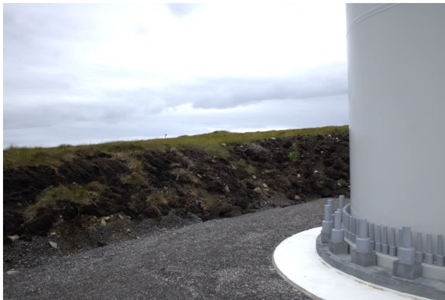
Figur 14: Nærbilde av inngrep ved vindturbin 6. Bildet er tatt av Gunnhild Rødstøl Ekrol.
