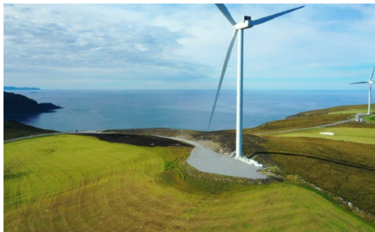
Figur 5: Dronebilde av vindturbin 1. Bildet er tatt av Silje Skarsten.
