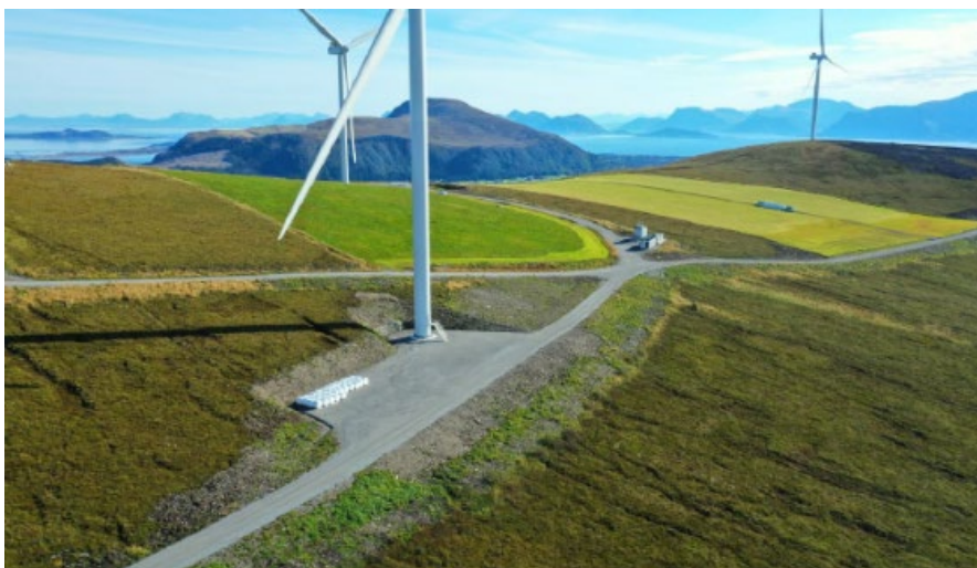
Figur 10: Dronebilde av vindturbin 4. Bildet er tatt av Silje Skarsten.
