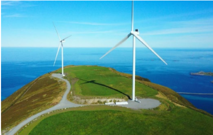
Figur 7: Dronebilde med vindturbin 2 i forgrunnen og vindturbin 3 i bakgrunnen. Bildet er tatt av Silje Skarsten.
