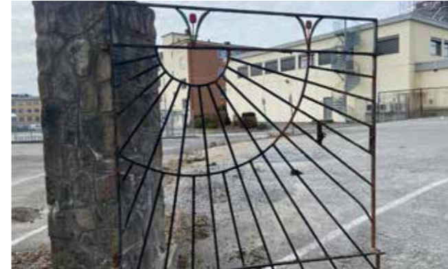
Figur 70: Port fra Os allé til driftsbygningen.
