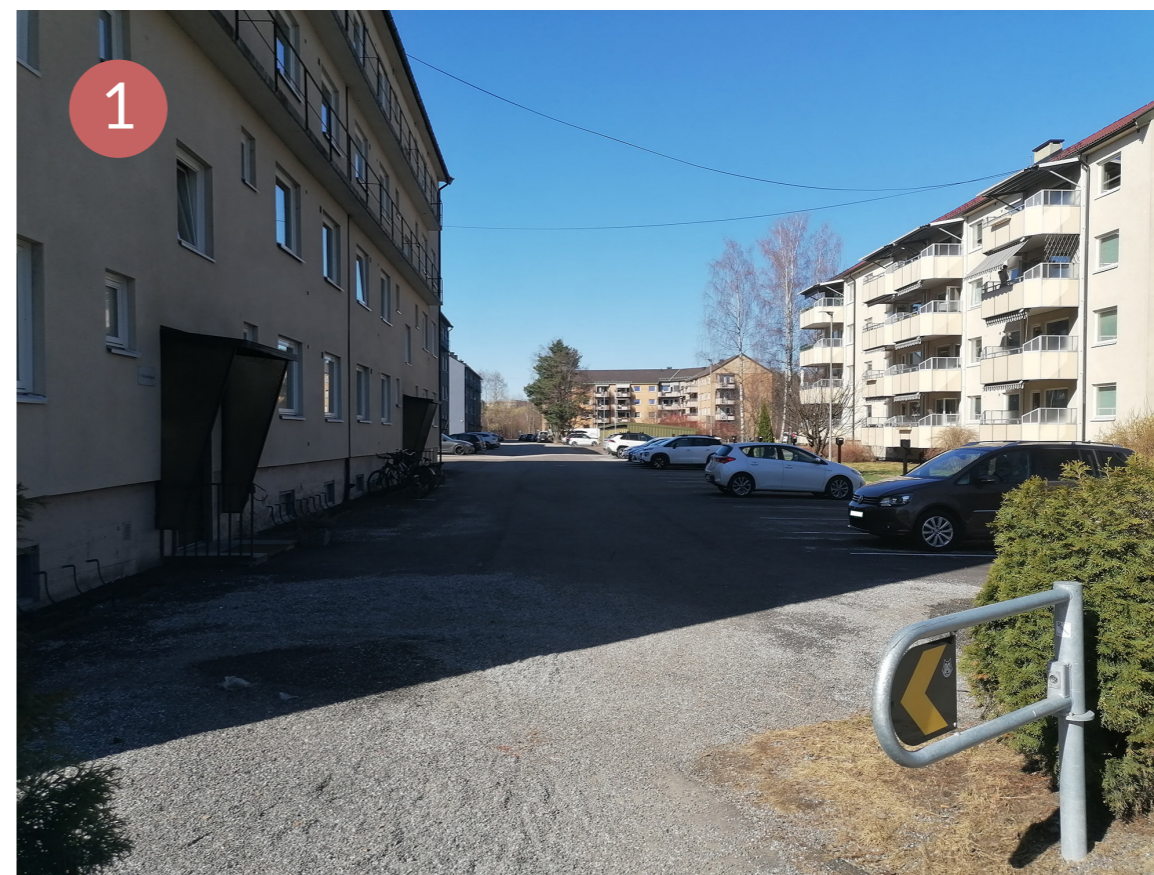
Figur 36. Adkomst 1, sett fra sørvest mot nordvest.
