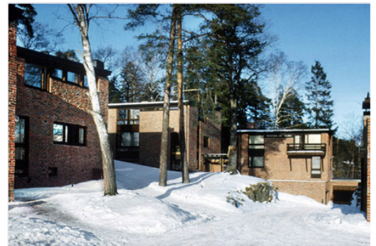
Figur 28: Bygningen følger terrengkottene og tilpasser seg landskapet. Terrengfallet opptas av underetasjer. Det er riktignok mer krevende å bygge i terreng med helning. {Byggeskikkknøkkelen., u.år #108}
