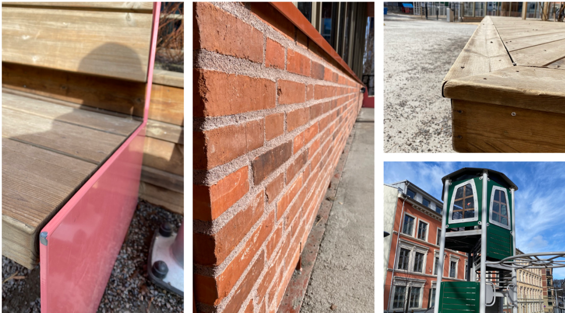
Bilde 10: Materialer på ruseløkka skole. Vestre benker (venstre), gjenbrukt teglstein i fasaden (midten), bestandig treverk og grønne lekeapparater som fremmer et «grønt» preg (høyre) Fotograf: Karminder Badhwar
