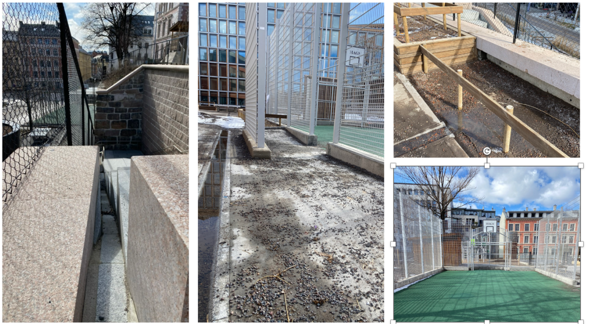
Bilde 9: Ulike løsninger for overvannshåndtering. Her ser man innslag av vannrenner integrert i trapper (til venstre), helning i uteområdet mot en nedsenket ballbinge (midten og nederst til høyre), og en av mange regnbed (øverst til høyre). Fotograf: Karminder Badhwar
