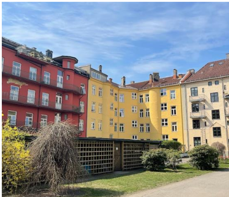
Figur 35: Selvtatt foto som viser brannbalkonger og enkeltstående Italiagården (2023).
