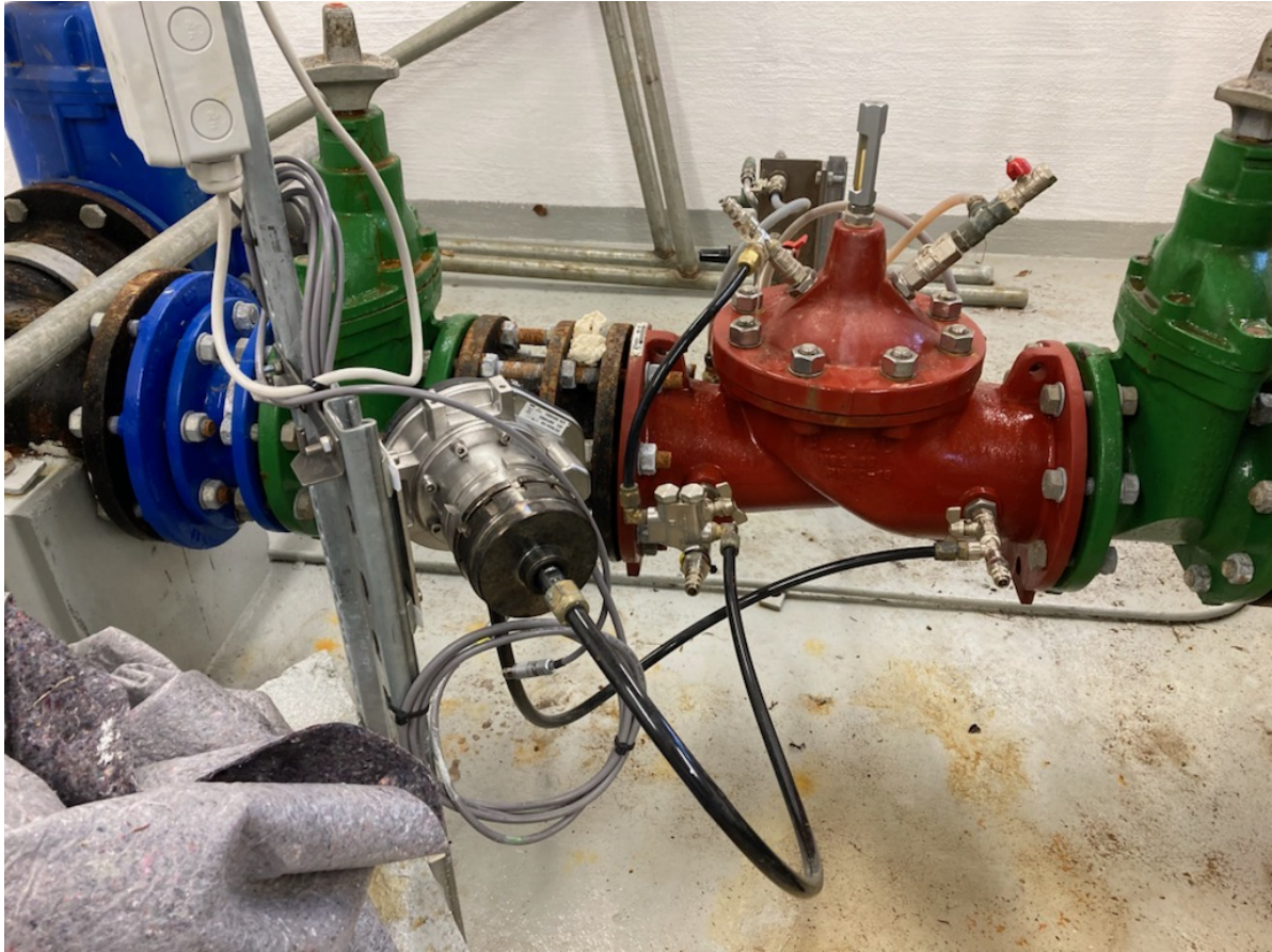
Figur 3.6: Trykkreduksjonsventil med aktuator fra i2O
