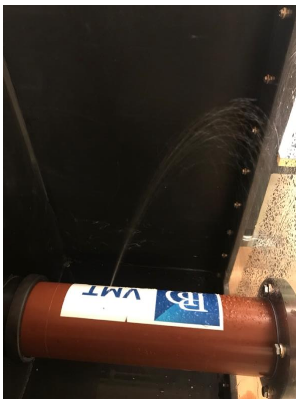
Figur 29: Bilde av utstrømning fra lekkasjehull på avløpsledning under testing av volumstrøm med hullplassering opp.
