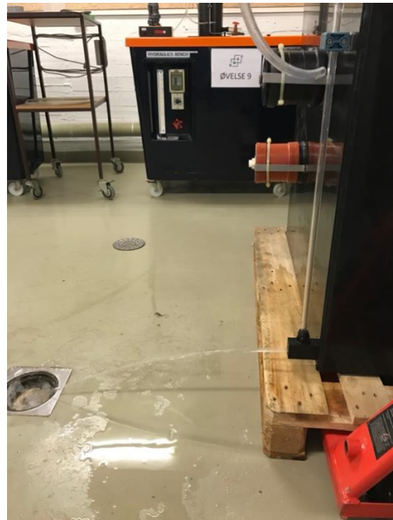
Figur 26: Bilde av utløp og stigerør ved tapping av grunnvann.
