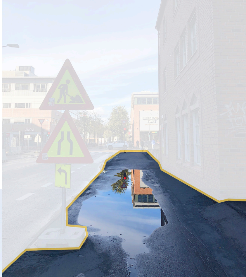
Problemer med overvann i Lillestrøms gater.
