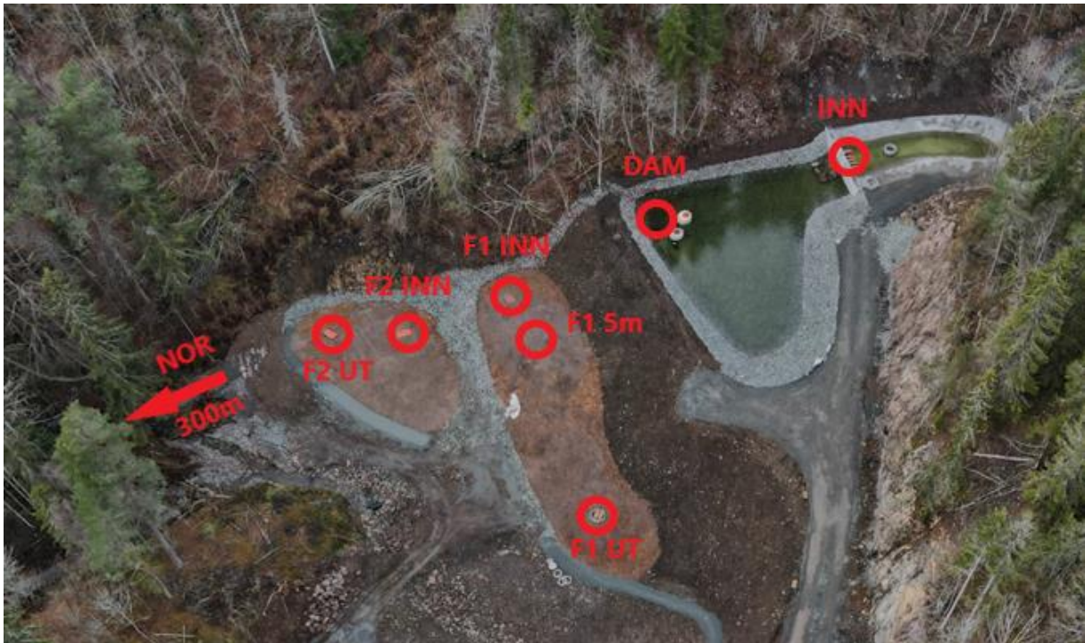
Figur 10. Loggestasjoner for vannkvalitet i rensanlegget (dronebilde, SVV. Illustrasjoner, Magnus Evang).
