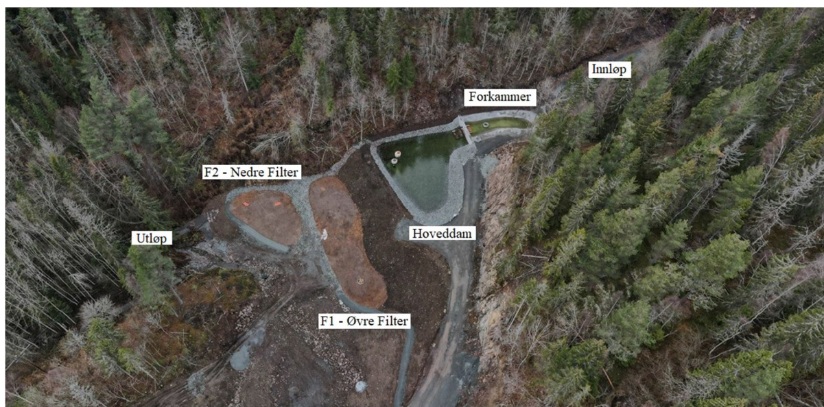
Figure 3. Dronefoto av anleggsområde til nitratfiltret ved Nordlandsdalen, med oppmerking av innløp, forkammer, hoveddam, F1, F2 og utløp. (foto: Statens Vegvesen).
