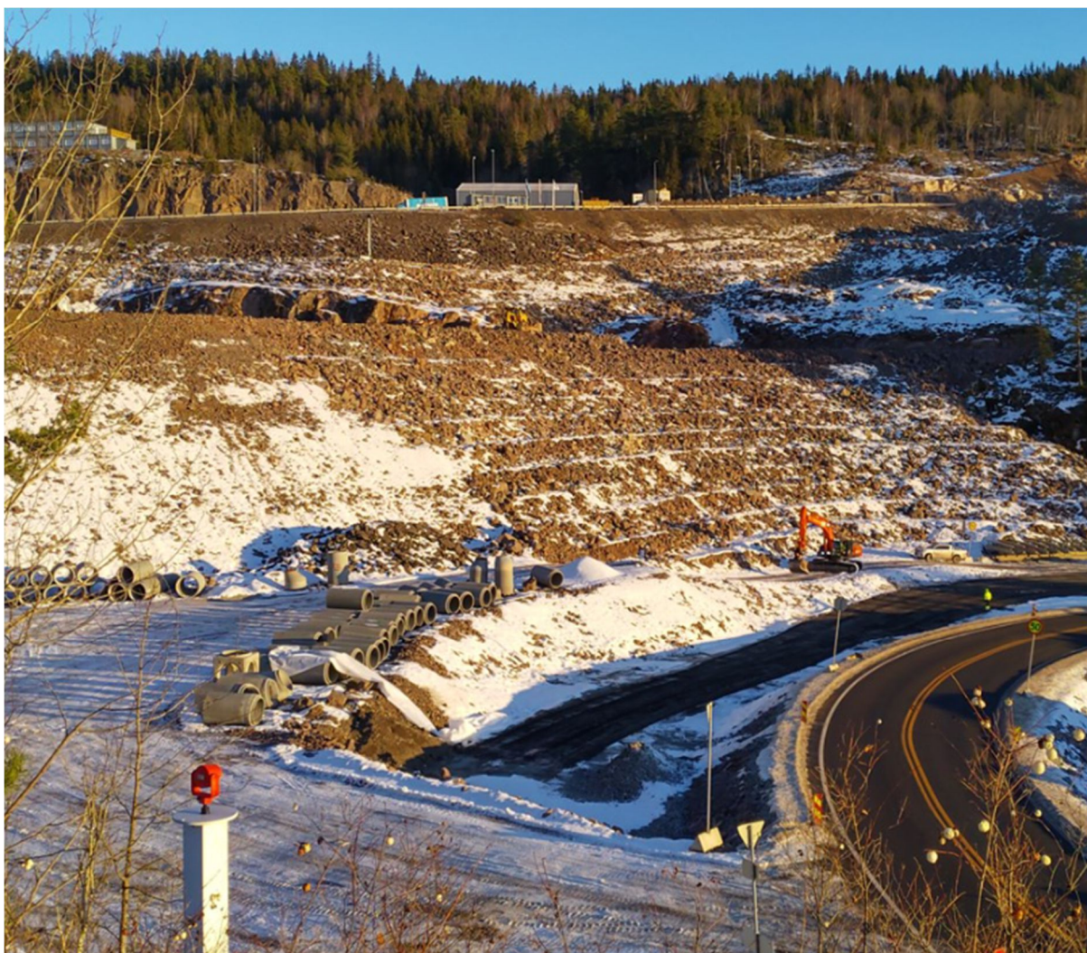
Figur 5 Sprengsteindeponiet i Nordlandsdalen. Massene består av 0,95 millioner m 3 dagsprengstein og 0,42 millioner m 3 tunnelsprengstein, bilde tatt av Statens Vegvesen.
