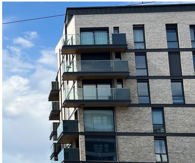
Figur 11: Stålprofiler og balkongene som intervjuobjektet viser til
