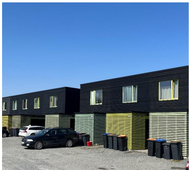
Figur 20: Eksempel på fargevariasjon på kalde konstruksjoner
