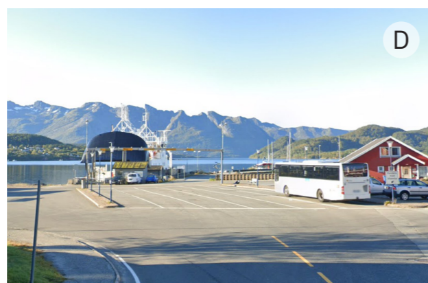
Figur 3.30: Bilde tatt mot sør, av Havneveien og ferjeleie
