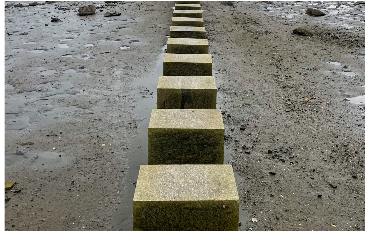
Figur 4.14: Bildet viser steine plassert med lik avstand og høyde over normalnull
