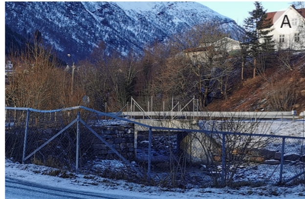
Figur 3.42: Bilde tatt oppover dalen, Mosvoldelva bak gjerdet
