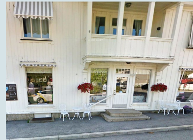
Figur 2.13: Det er mange aktive fasader i Ringebu. Her er et typisk eksempel på en inviterende butikkfasade, med detaljrik utforming, møblering og beplantning. Utklipp fra Google streetview.
