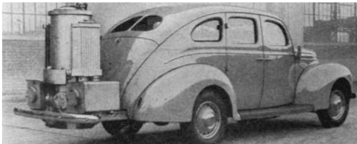
Figur 2: Kjøretøy ombygget til kjøring på tregass (Norsk Scania AS, 2023).
