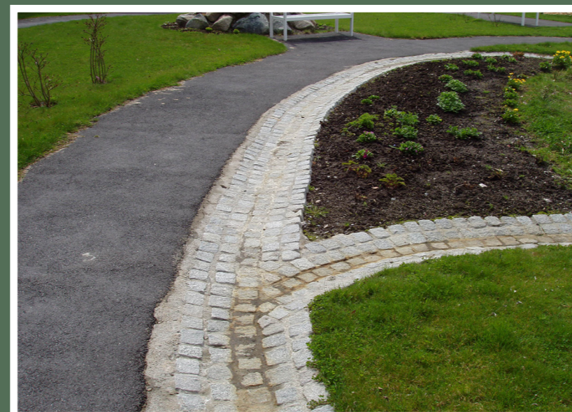
Figur 4.13: Vannrennen av brostein leder takvann til vanddammen.
