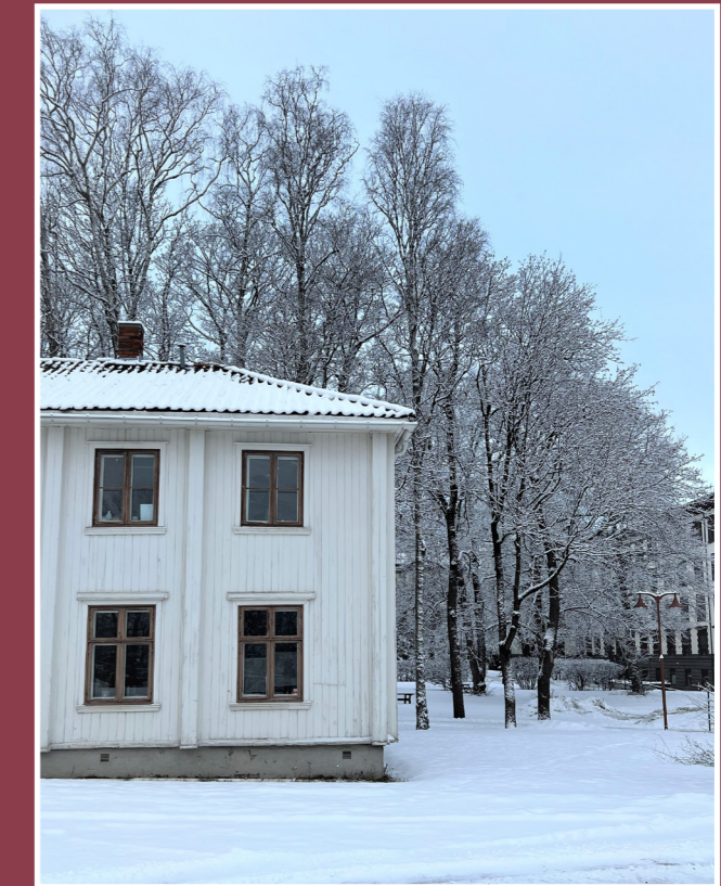
Alle vinduene på Løkkehuset har brune karmar.
