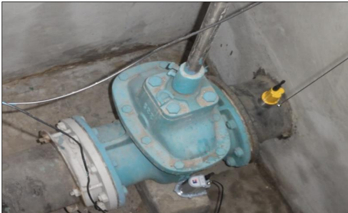
Figur 6: Lekkasjeøk ved bruk av en logger som er plassert på et rør (Reetaj Technologies, 2008).
