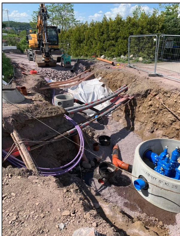
Figur 34: Utgraving og fornying av ledningsnett. Foto tatt under befaring.
