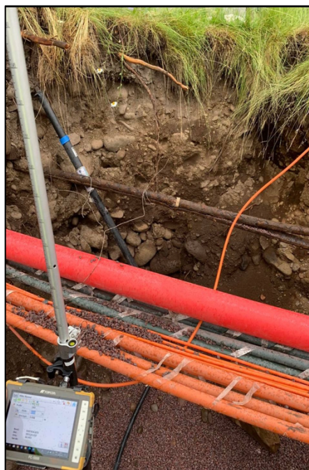
Figur 5: GPS for fasemåling i felt. (Bilde tatt under innmåling av stikkledning.)
