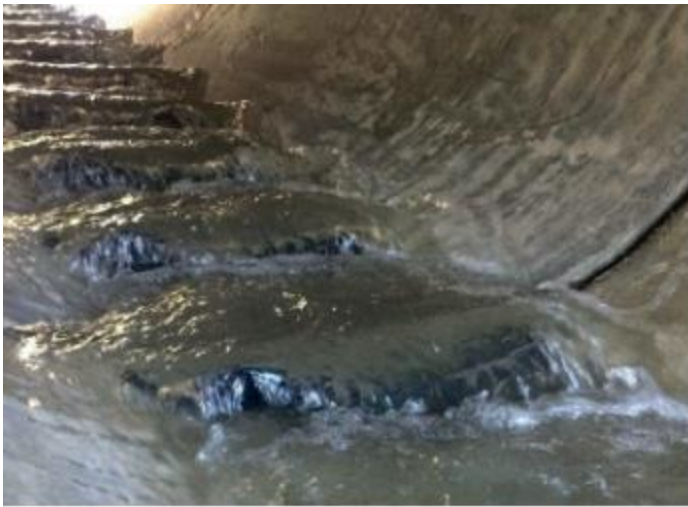
Figur 9. Såkalte «fleksiterskler», som sørger for at vannstrømmen gjennom kulverter og stikkrenner ikke blir for stri og monoton uten «hvileplasser» for fisk (Basal AS, 2023).
