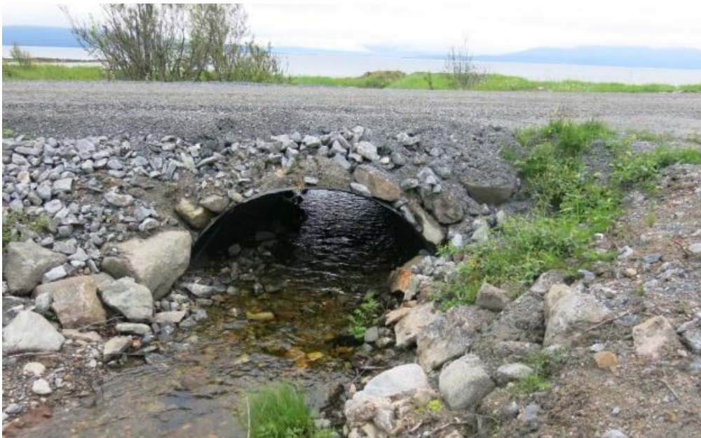
Figur 3. Hvelvkulvert som ivaretar elvebunnen og vandringsmuligheter for både fisk og andre dyr dersom kulverten dimensjoneres bredere enn selve vassdraget. Raus dimensjonering vil også gjøre løsningen bedre rustet for flom (foto: Haugland og Hjelle, 2015)
