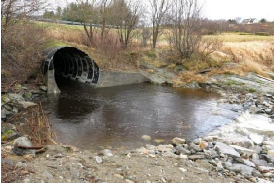
Figur 7. God rørkulvertløsning i Ulvangselva i Leirfjord Kommune i Nordland, med opparbeidet terskel for heving av vannspeilet inn i kulverten (foto: Lars Aage Gade-Sørensen)
