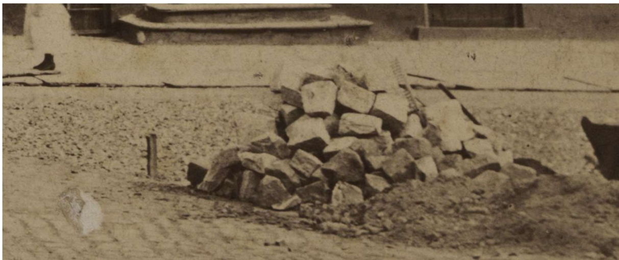
Figur 19: Brosteinsarbeider fra Torget på 1860-tallet. Noen av brosteinsformatene har tydelig sideflater som er hugget skrått, samt rektangulære toppflater. Foto: (Selmer, 1862-1869)
