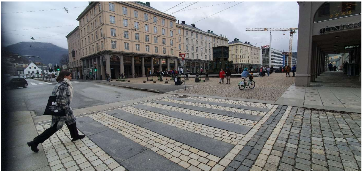
Figur 51: Et eksempel på en av flere overgangsfelter der storgatestein er rettsatt med fast forbandt. Foto: (Ørnbo, 2023)
