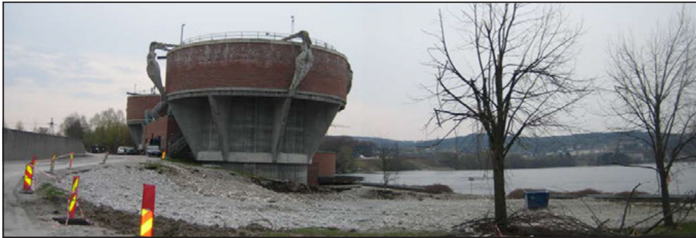
1. Riving av tanken ved rensanlegget.
