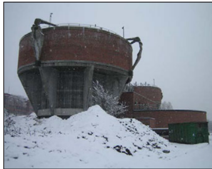
Renseanlegget på Vestfronten.
