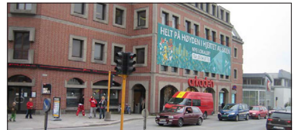
5. Arkadens fasade mot Laugstolparken.
