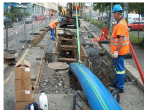
Figur 15: Utblokking i praksis, nytt rør føres inn i grøfteåpning - VA Miljøblad 90
