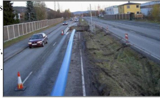
Figur 14: Illustrasjon av nytt rør som innføres i gammelt rør under bakken – VA Miljøblad 90
