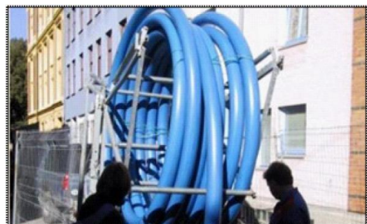
Figur 13: Nytt rr på kveil fra fabrikk - VA Miljøblad 90
