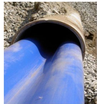
Figur 19: Tettisluttet rør, utforming ved innføring - VA Miljøblad 90
