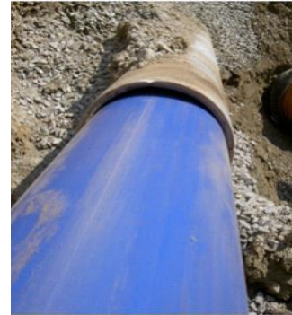
Figur 20: Tettisluttet rør, etter tilføring av varme og trykk går røret tilbake til opprinnelig str. - VA Miljøblad 90
