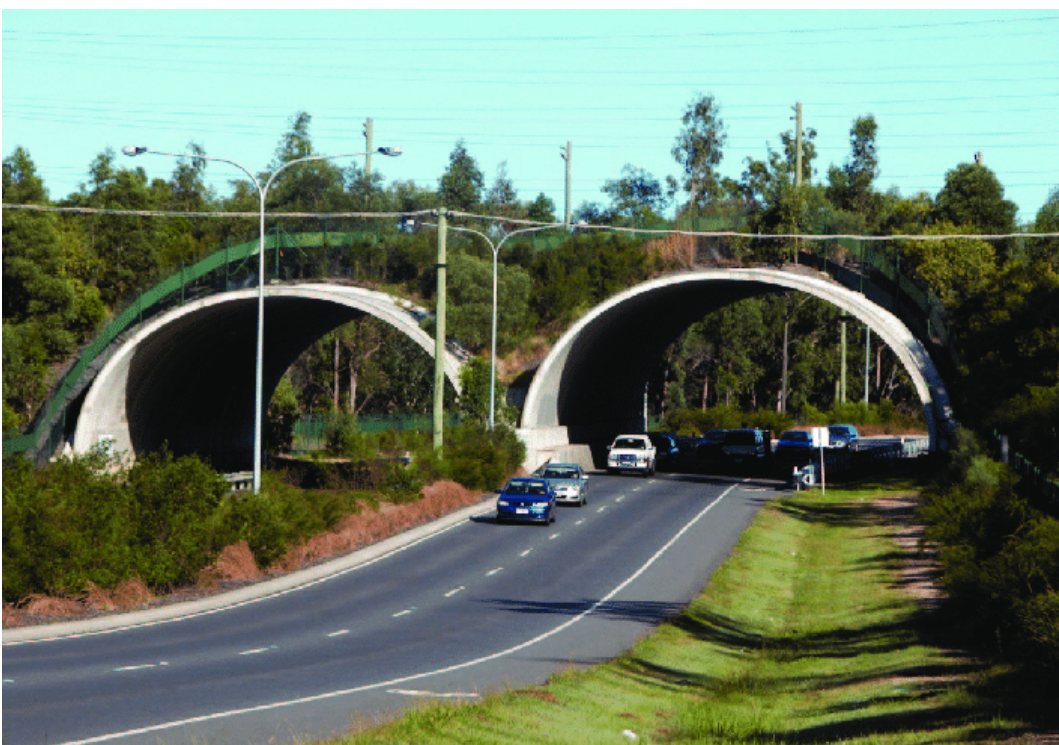
Figur 6 – Viser broen i Brisbane med tilrettelagt viltovergang. (Blacker & Jones, 2014)
