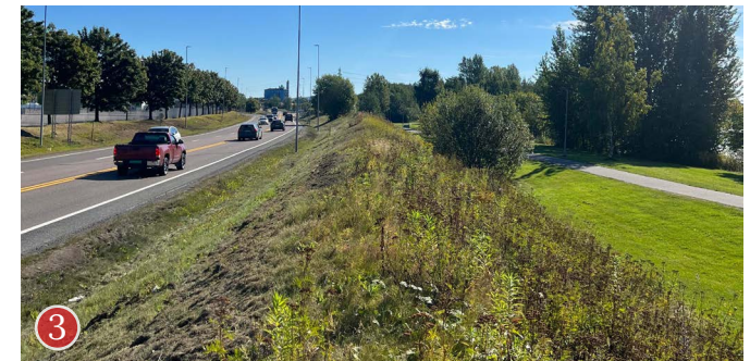
3 Flomvollen som skiller Rv159 og turveien langs med Nitelva – Bildet viser forholdet mellom Rv159 til venstre og turdraget til høyre med flomvollen i midten.
