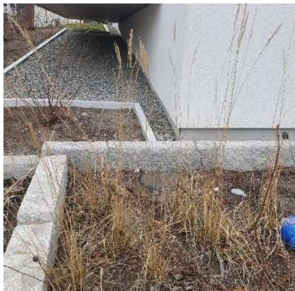
Figur 121. Molinia caerulea . Beplantning 3. Lørenvangen borettslag, Oslo. 07.04.2022
