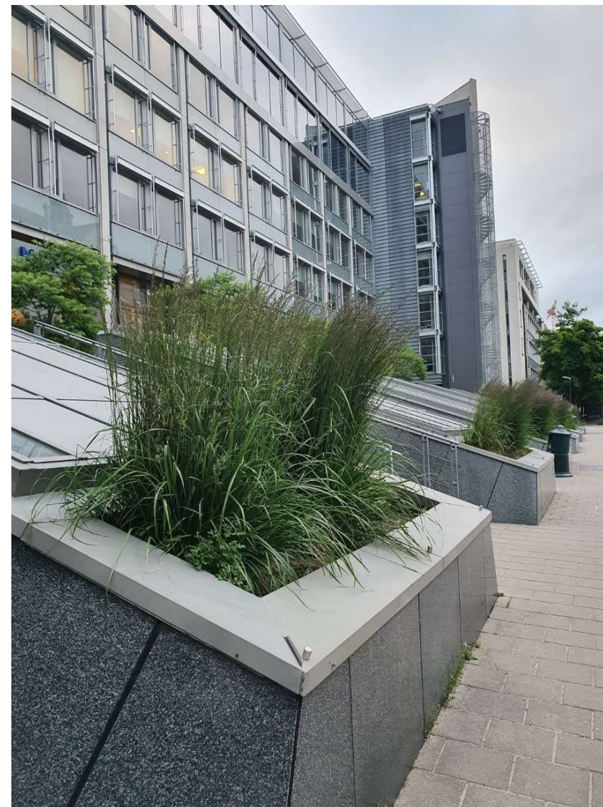
Figur 36. Beplantningskasse 2, med 3-6 i bakgrunnen. Nordeahuset. Majorstua, Oslo. 23.06.2022
