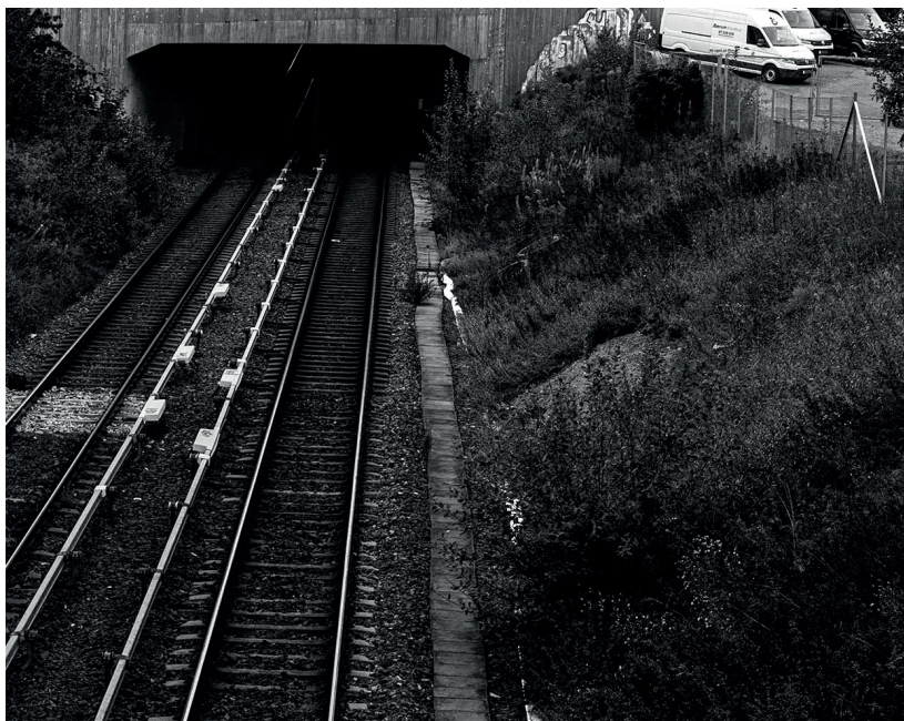
Ved Økern T-banestasjon i retning Risløkka
