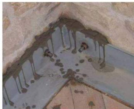
Figur 23 – Forsterkning av forbindelse mellom gulvskiver og vegger (Meganes et al., 2014).
