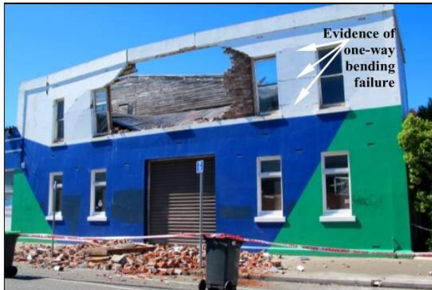
Figur 11 - Skader fra en-veis utbøyning ut av planet.
