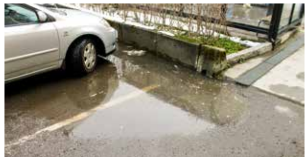
Overvannsproblematikk på lokket
