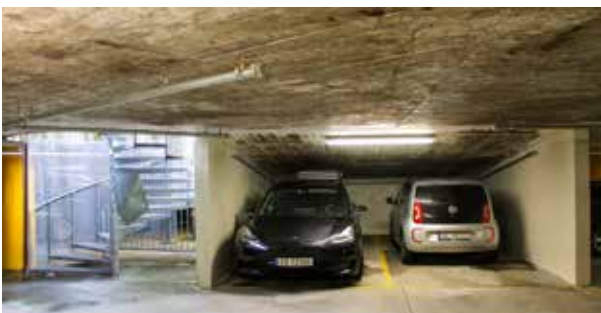
Parkeringsanlegget og tilgang via dagens trappelhus
