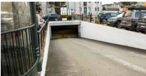
Nedkjøring til parkeringsanlegget
